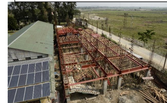
चित्रा 2.14 निर्माणाधीन नई प्रयोगशाला
